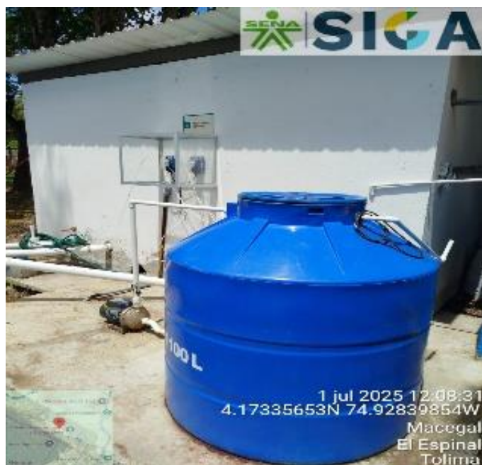
Tanque homogeneizador de cloro con bomba de 1 Hp
