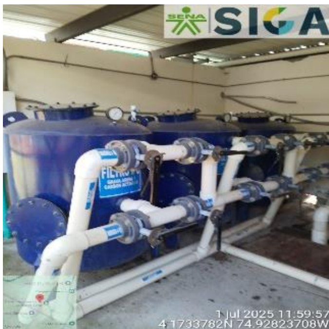
Tanques filtración de agua cruda
